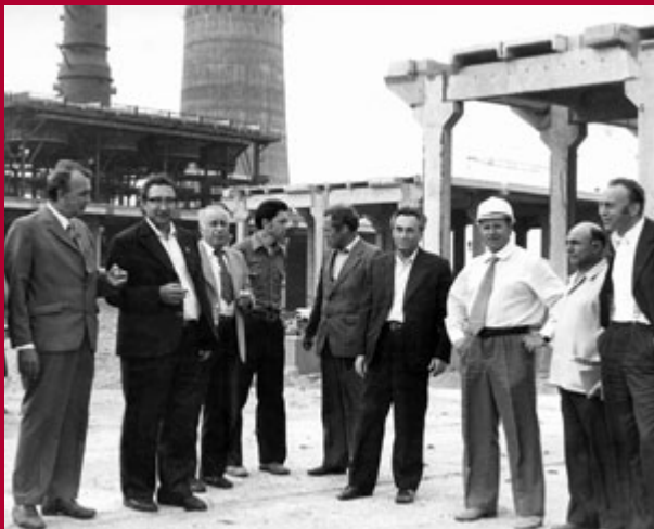
Строительство одной из установок ОНПЗ, 1984
