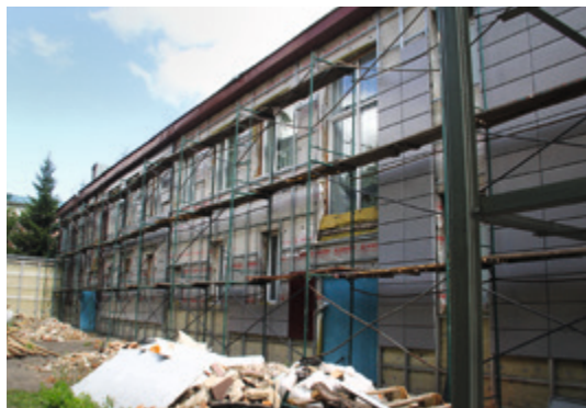
Ремонт фасада ДШИ № 2
