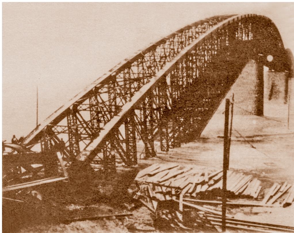
Взорванный колчаковцами железнодорожный мост через Иртыш. 1919. Из книги «Кировский округ: прошлое, настоящее, будущее» (Омск, 2008)
