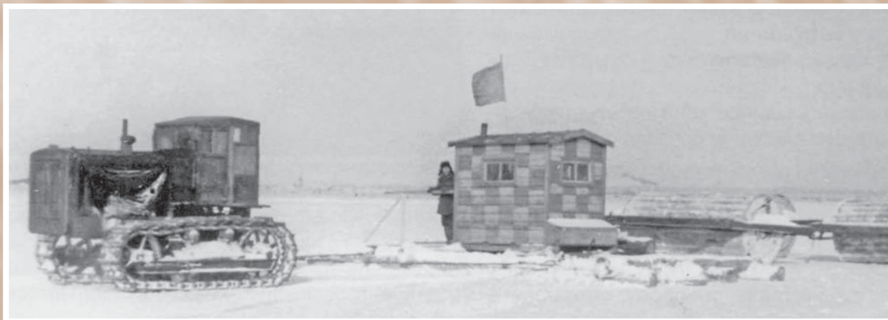
Укатка поля в Омском аэропорту*. 1940-е
