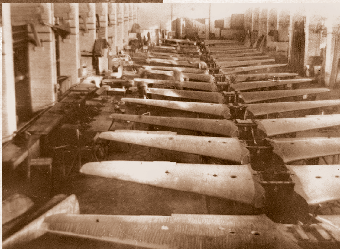
В сборочном цехе завода № 166. 1944
