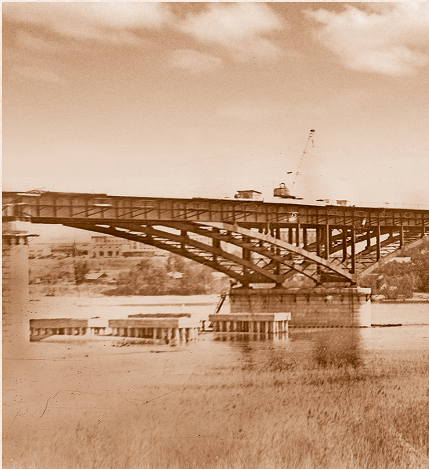
Строительство моста им. 60-летия ВЛКСМ (у телецентра). 1970-е
