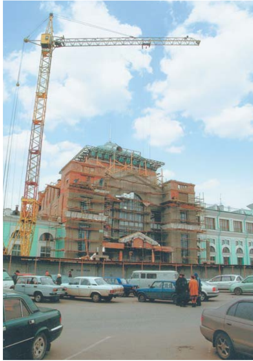
Реконструкция железнодорожного вокзала 18 . 2006
