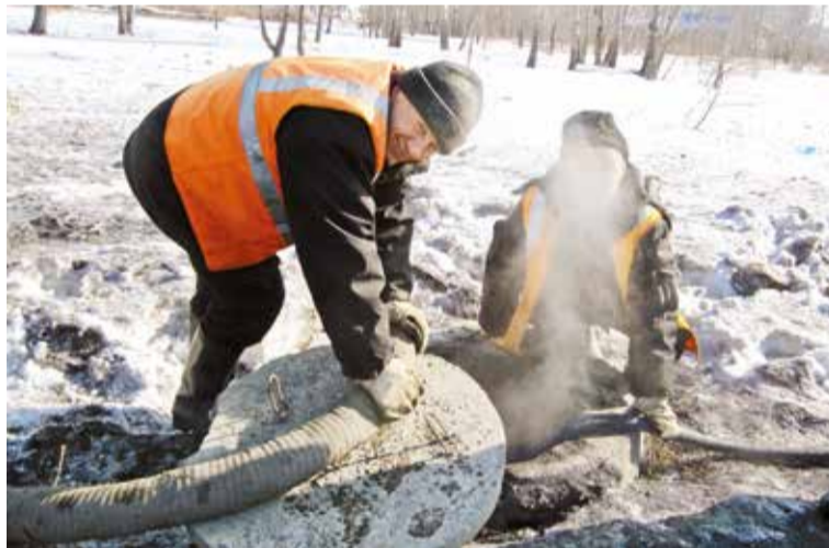
Работы по предотвращению подтопления тальми водами ведутся в ежедневном режиме
