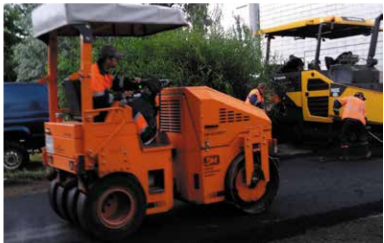
Аварийно-восстановительные работы завершат в сентябре
