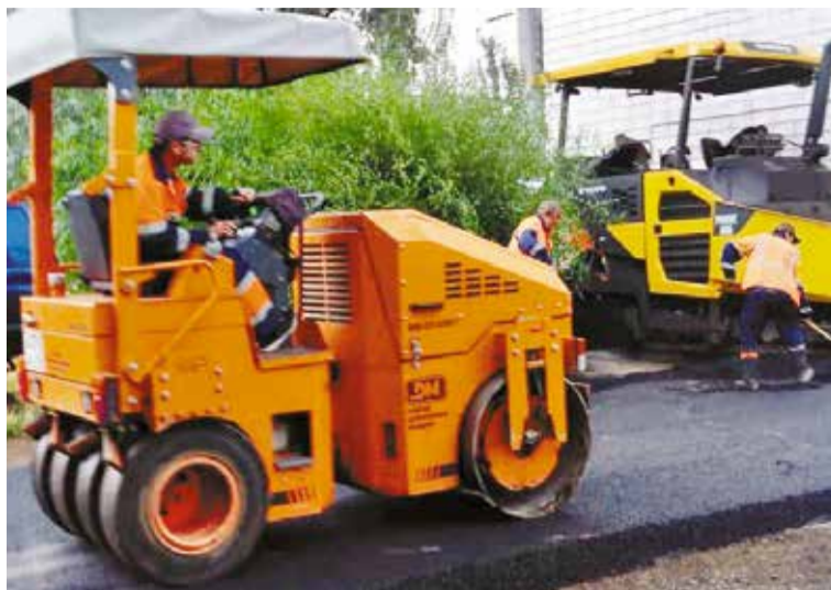
Благоустройство дворовых территорий выполнено в срок
