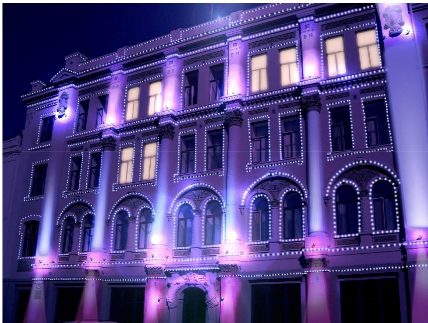
Пример оформления фасада здания Администрации города Омска.
