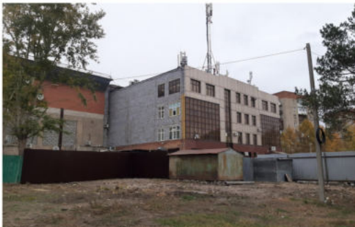
9. Хозяйственная зона КДЦ - необходимо барьерное озеленение
