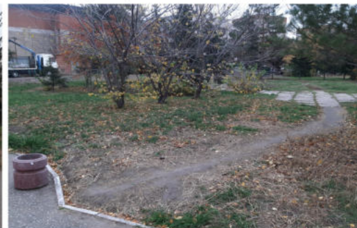
15. Отсутствие твердого покрытия на пути движения пешеходов
